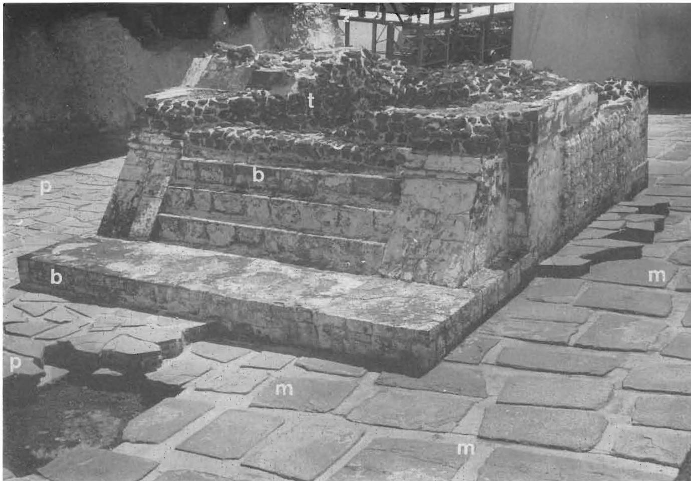
7. Edificio B. Plataforma, alfardas, escalinatas y fachadas revestidas con pequeños bloques de basalto (*b*); relleno de tezontle (*t*); pisos de andesita de lamprobolita (*m*) y de andesita de piroxenos (*p*). Fotografía de L. López Luján
