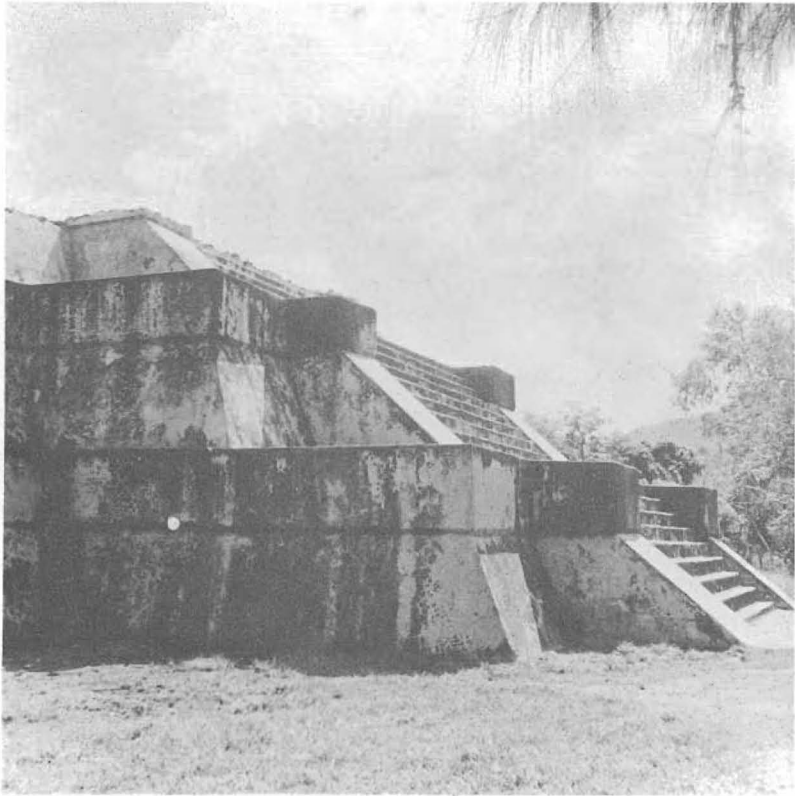
FIG. 13. Estructura B-2 de Tazumal, El Salvador. Alfardas con remate vertical o "dado".
